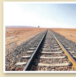
بخش داخلی داده‌اند. مدیر کل راه آهن شمال شرق کشور پروژه اتصال ایستگاه شادمهر در شهرستان مه ولات به رشتخوار را حاصل چند سال تجربه کاری در زمینه رفع مشکلات ترافیک ریلی منطقه دانست و افزود: با اتمام و بهره‌برداری از این پروژه، افزون بر کوتاه شدن ۳۰ کیلومتری مسافت به دلیل تردد نکردن قطار به تربت حیدریه، بیش از ۶ ساعت هم از توقف قطار به دلیل ترافیک بالا در ایستگاه راه‌آهن تربت حیدریه جلوگیری می‌کند. اقبال با اشاره به بارگیری ۴۰ تنی حمل و نقل ریلی کل کشور در سال گذشته و سهم ۵ میلیونی خراسان از این میزان، ساخت پروژه شادمهر - سالار را در راستای پروژه اتصال کاشمر به بافق دانست و بیان کرد: در راستای برنامه افق ۲۰ ساله، بارگیری سگکان در سال ۱۴۰۴ حدود ۲۶ میلیون تن پیش بینی شده است و این حجم مناطق، راه آهن را مجبور می‌کند با تلاش مضاعف ظرفیت حمل و نقل ریلی منطقه را در راستای اهداف کلان اقتصادی به میزان مطلوب برساند. نماینده مردم شهرستان‌های مه ولات تربت حیدریه و باده در مجلس شورای اسلامی ضمن اشاره به نامتوازن بودن امکانات و پیشرفت‌های غرب و شرق کشور بیان کرد: اگر کشور را به دو نیمه غربی و شرقی تقسیم کنیم، نیمه غربی کشور از لحاظ توسعه ریلی، تعداد فرودگاه‌ها و بزرگراه‌ها
