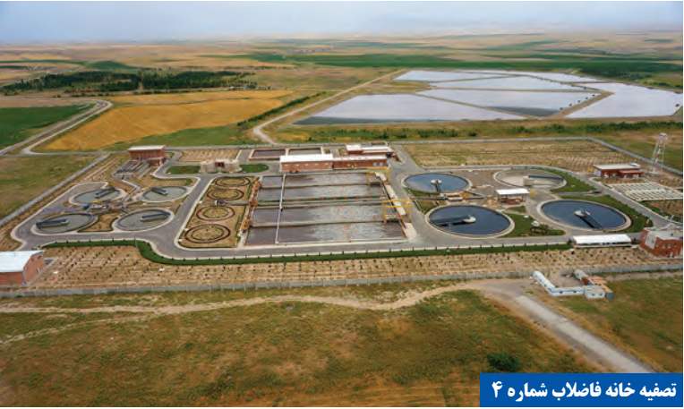
تصفیه خانه فاضلاب شماره ۴
